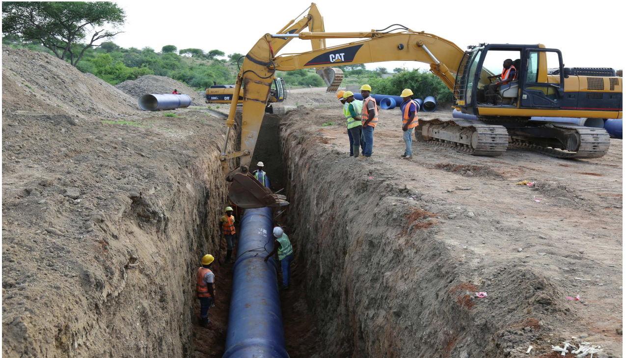
Ulazaji wa bomba kuu la maji ukiendelea katika mradi wa maji Same – Mwanga – Korogwe.
