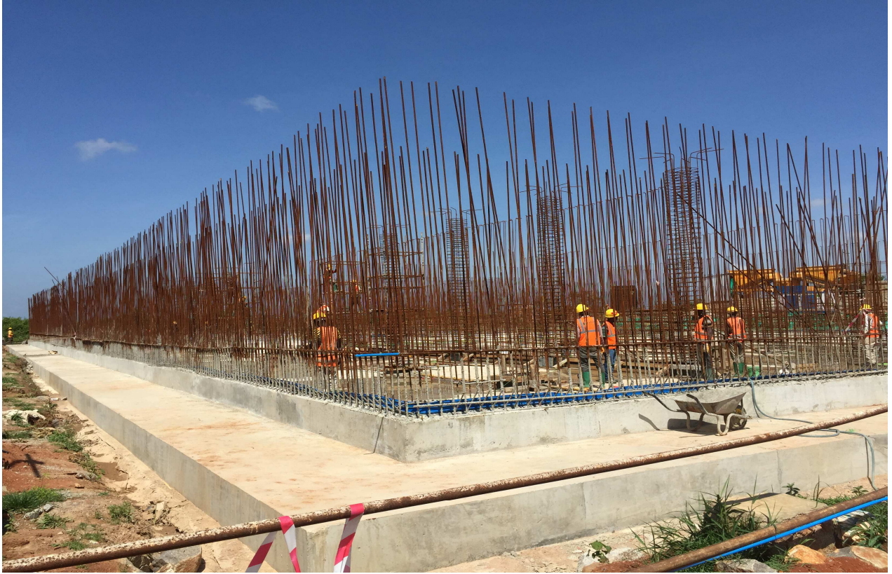
Kazi ya ujenzi wa tanki la kuhifadhia maji lenye ujazo wa lita 9,000,000 ikiendelea kwenye eneo la Mlima Itumba Mjini Tabora. Tanki hilo ni miongoni mwa miundombinu ya maji inayojengwa katika mradi wa kutoa maji bomba kuu la KASHWASA kupeleka kwenye Miji ya Tabora, Igunga, Nzega na Wilaya ya Uyui.
