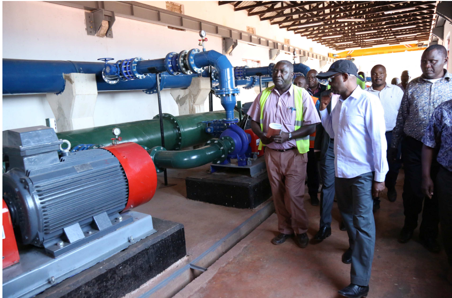
Waziri wa Maji Mhe. Profesa Makame Mbarawa (mwenye kofia) akikagua ujenzi wa mradi wa maji Kigoma Ujiji Mkoani Kigoma
